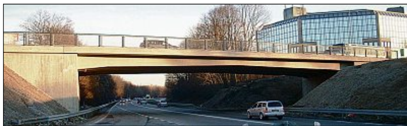
Die Behelfsbrücke (oben) und die neue Brücke.
